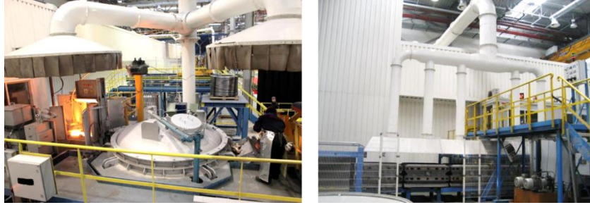
(Fig. 1) A la izquierda un colector doble ducto de extracción en horno de vaciado y (Fig. 2) a la derecha múltiples puntos de extracción en una línea de moldeo
