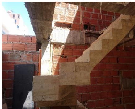
Figura 4. Escaleras salidas del área limitante.
